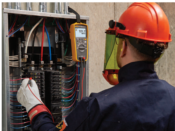
Рис. 2. Мультиметр-тепловизор подвешивается на ремне при измерениях с помощью щупов
